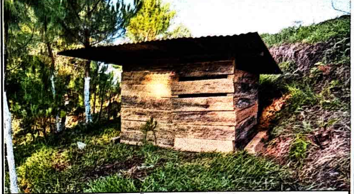
Foto 2: SUSTITUCION DE BAÑO POR DETERIORO
