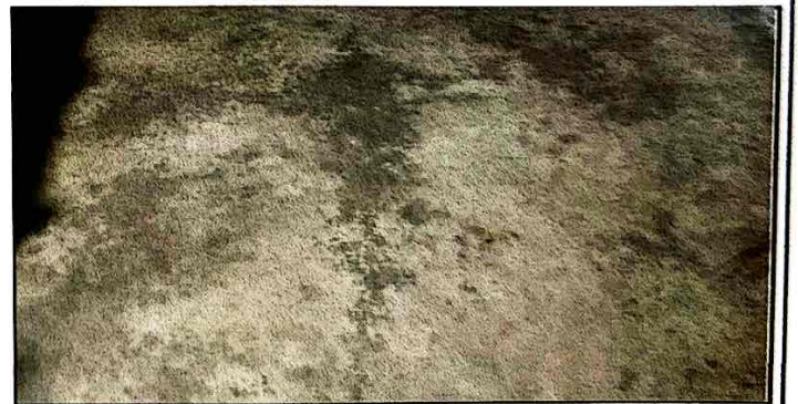
Foto 6: SUSTITUCIÓN DE PISO A CERAMICO
