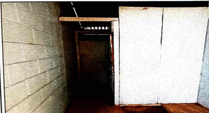
Foto 3: SUSTITUCION DE PUERTA POR DETERIORO
